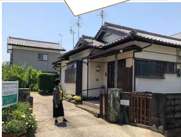
閑静な住宅地にある30坪程度の平屋
